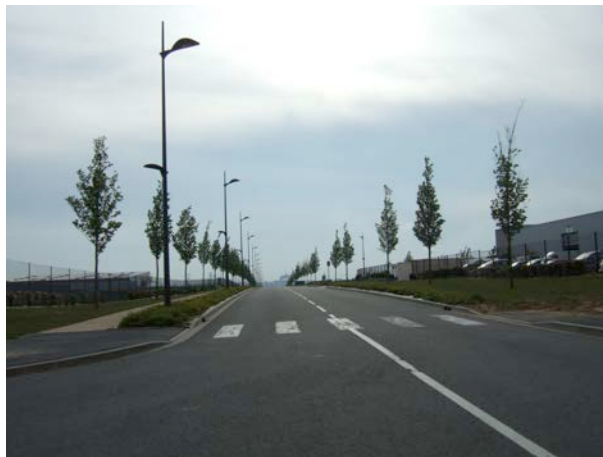
Profil de voirie dans le Parc d'activités des Autoroutes
