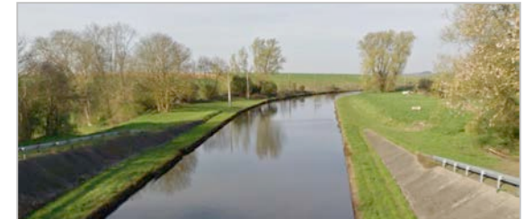
Vue sur le Canal de Saint-Quentin depuis la N44
