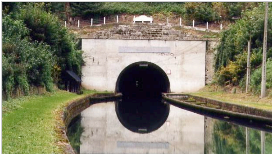
Le passage du tunnel est réalisé grâce à un toueur.
