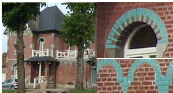
La couleur sur les façades constitue un signe distinctif de cette époque.
