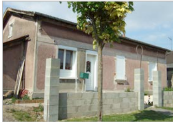
Exemple d'une construction typique de la cité Séblin, actuellement en cours de rénovation.
