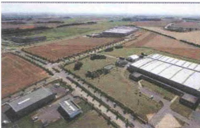
Parc des Autoroutes A26/A29 à Saint Quentin
