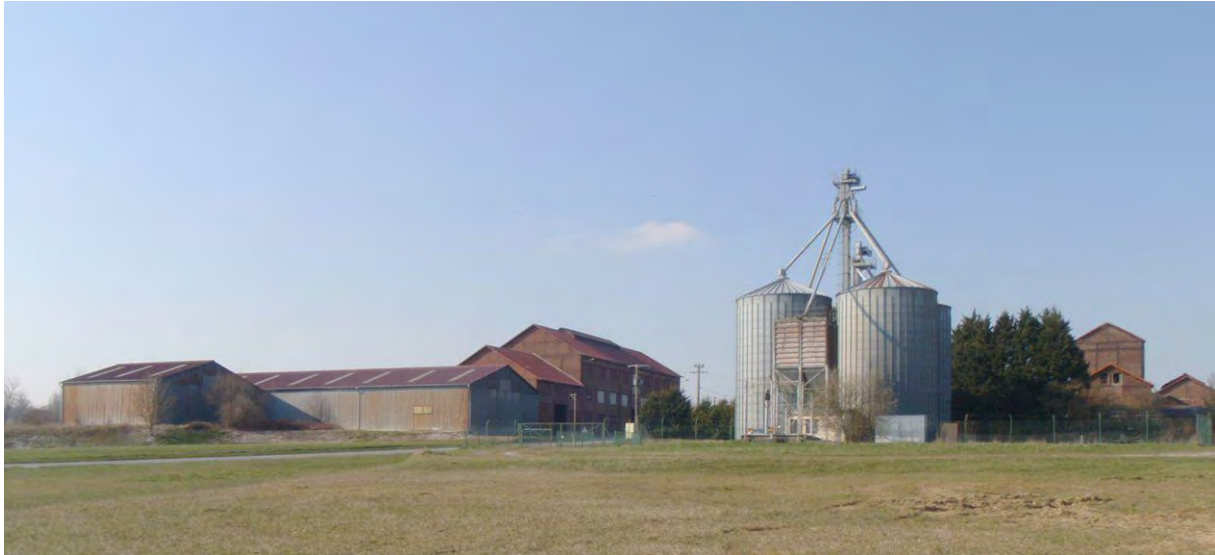
SILOS DE « LA CARRIÈRE »
