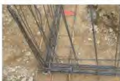
Nœud de chaînage - Continuité mécanique
